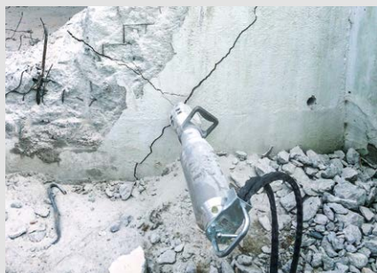
Abbruch von Beton und Stahlbeton
