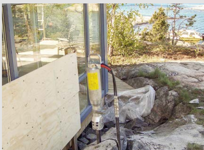
Abbruch von Fels und Naturstein
